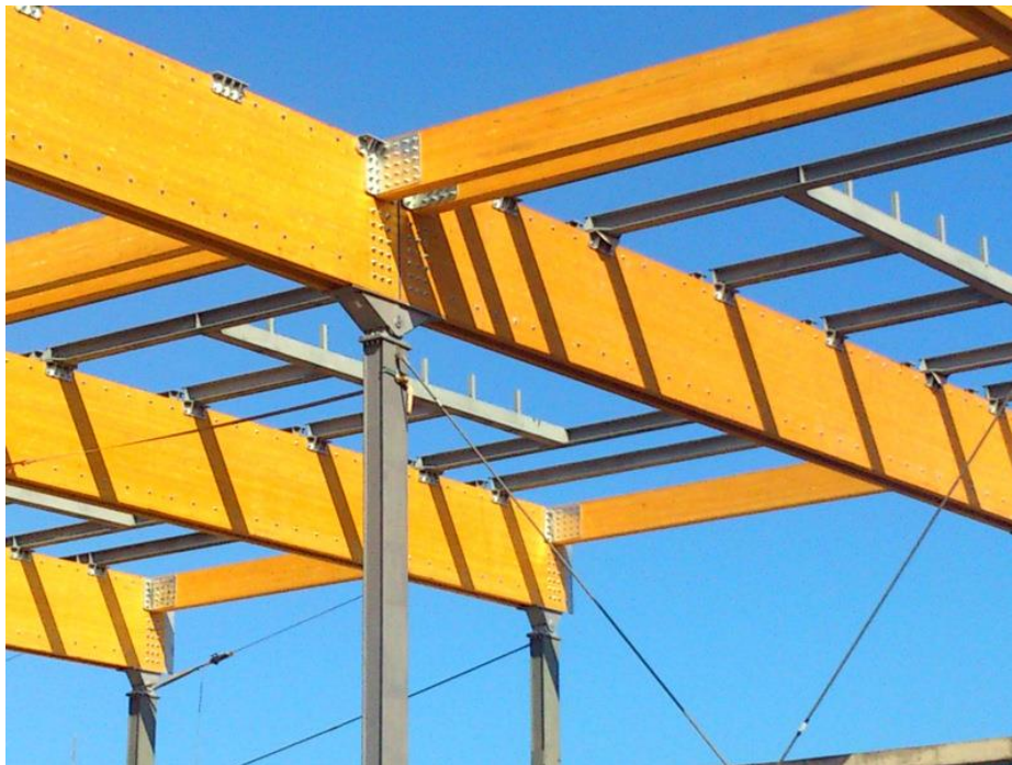
Figura 8. Estructura de cubierta durante la ejecución.
