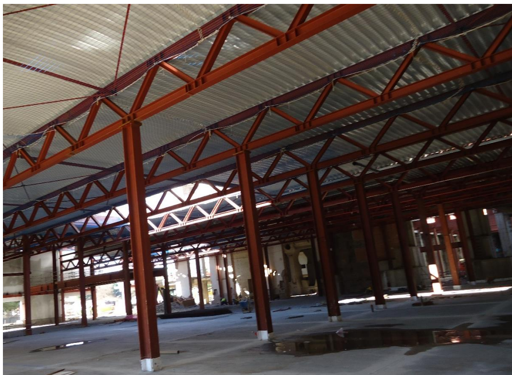
Figura 6. Celosías de cubierta durante la ejecución del edificio Nuevo.
