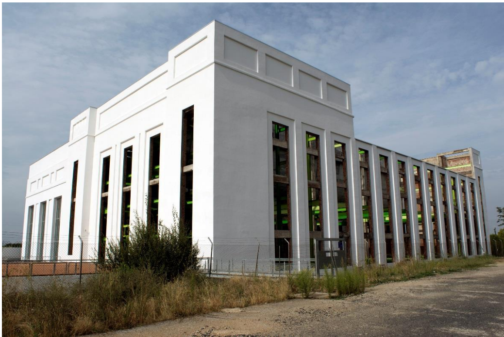
Figura 7. Edificio de Calderas con estructura terminada.
