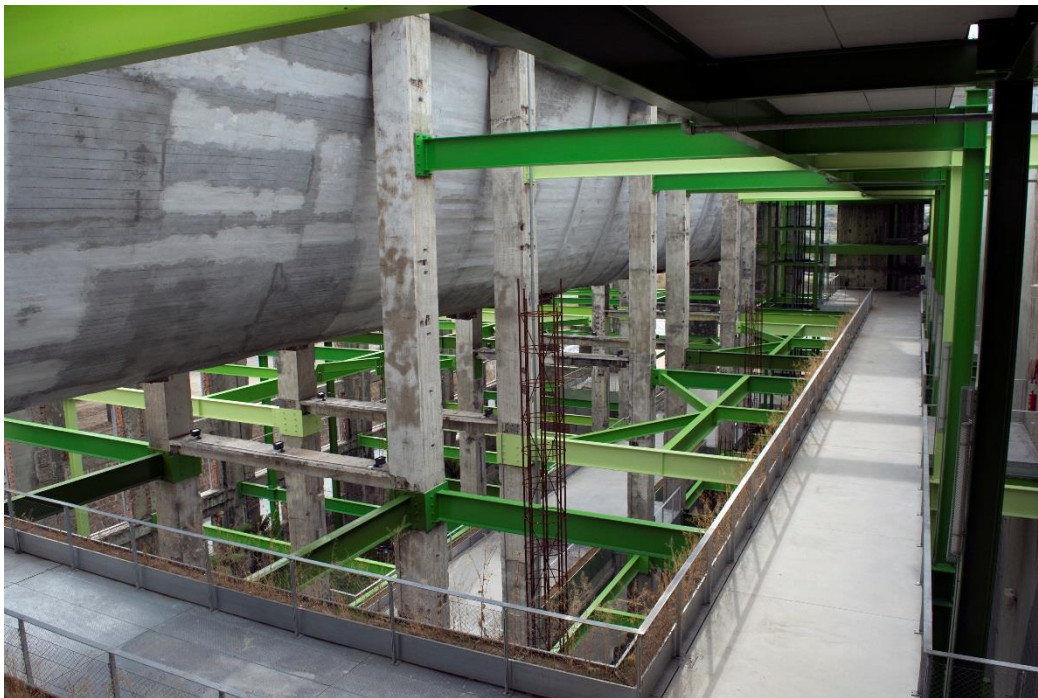
Figura 10. Interior edificio de Calderas.
