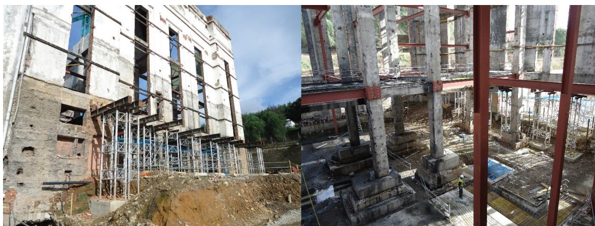
Figura 11. Sistema de Apeo y estabilización fachada este Edificio de Calderas.
