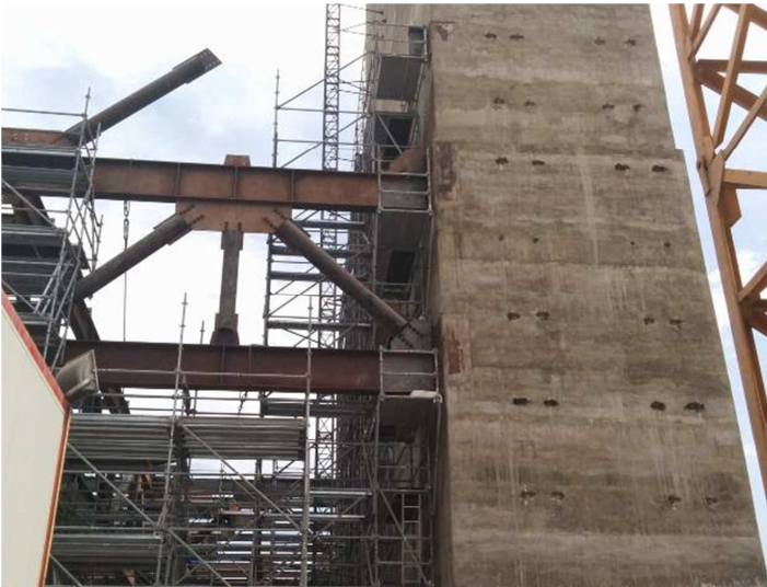
Figura 7. conexión núcleos de hormigón / celosías metálicas
