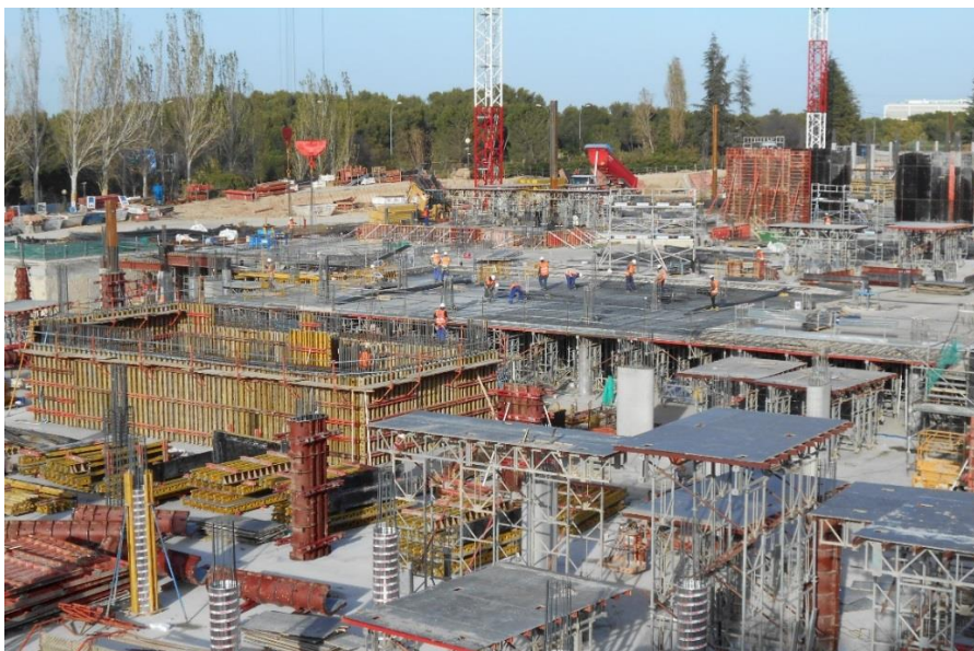
Figura 2. Mesas Hussor en la obra.
