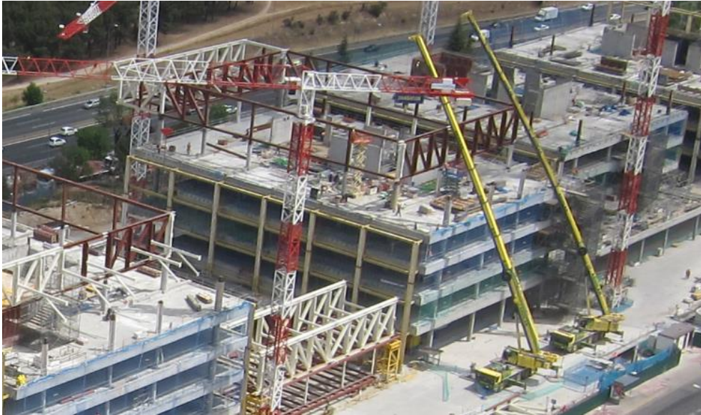
Figura 7. Montaje de celosías.
