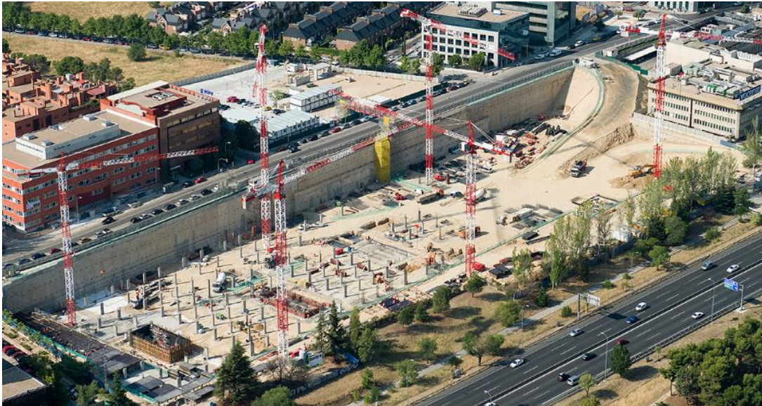
Figura 1. Implantación de grúas.
