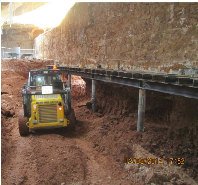
Figura 11. Detalles de apeo de contramuralla
