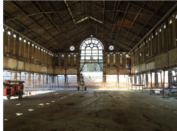
Figura 5. Apeo de estructura
