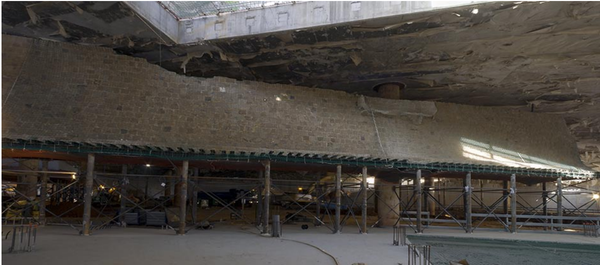
Figura 10. Vista general de apeo de contramuralla
