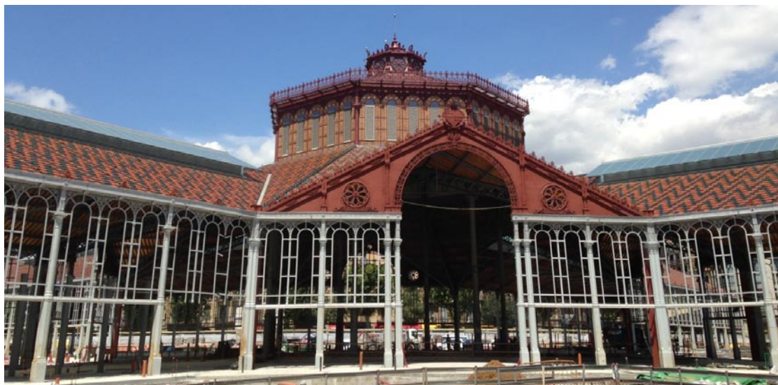
Figura 13. Vista general de la estructura rehabilitada
