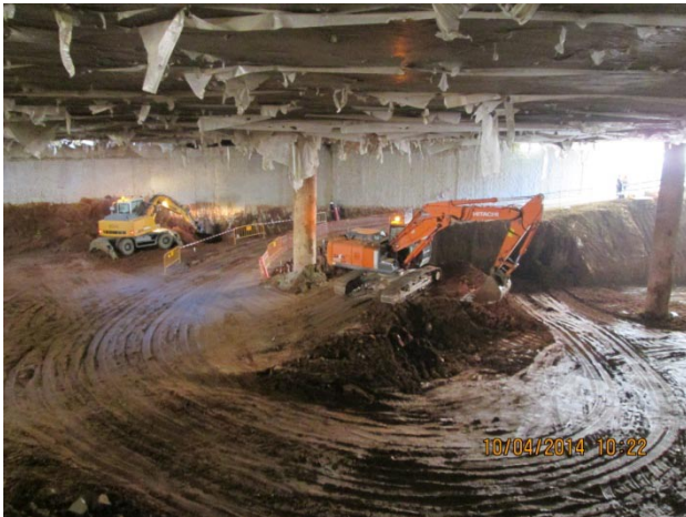
Figura 7. Excavación bajo losa con medios convencionales
