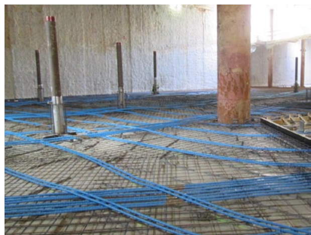
Figura 8. Vista general y detalle de pilas-micropilote
