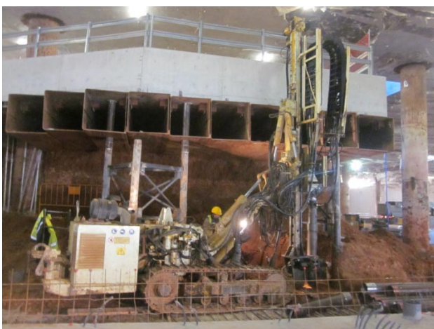
Figura 8. Vista general y detalle de pilas-micropilote
