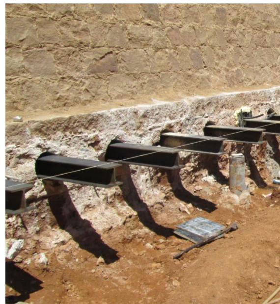
Figura 11. Detalles de apeo de contramuralla
