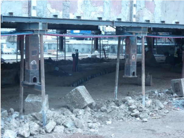
Figura 5. Apeo de estructura
