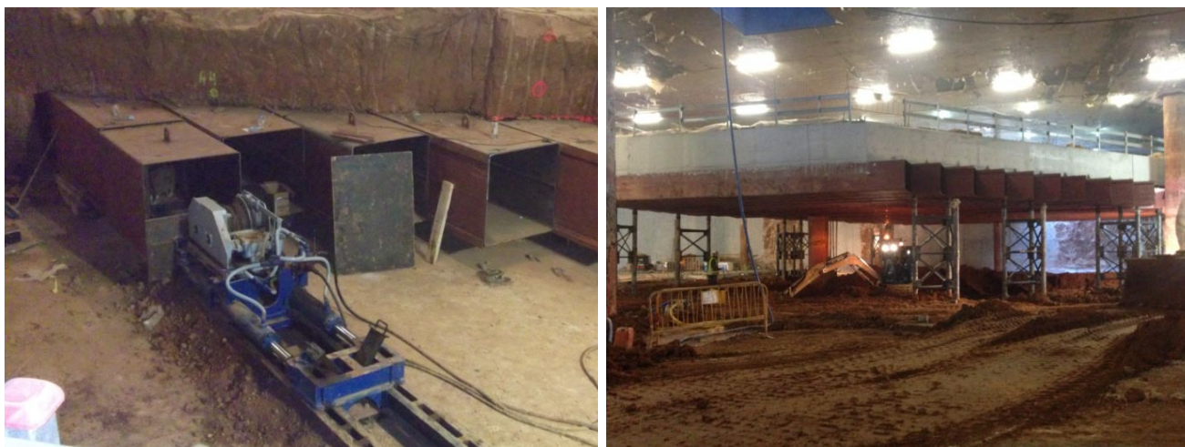
Figura 9. Ejecución de cajones hincados y vista general del apeo
