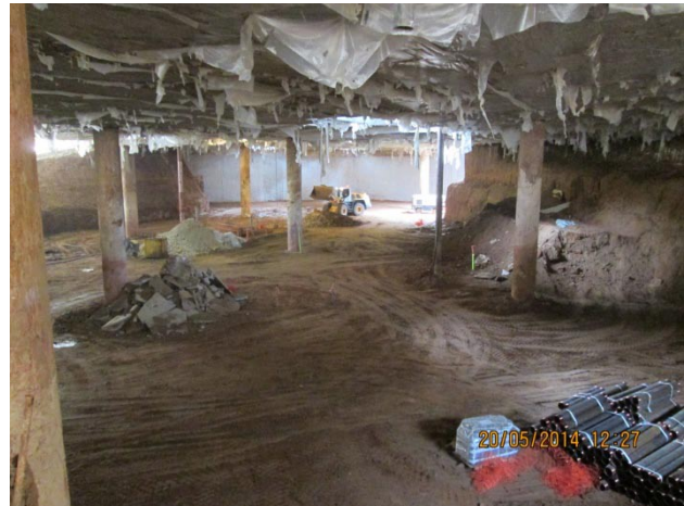
Figura 7. Excavación bajo losa con medios convencionales
