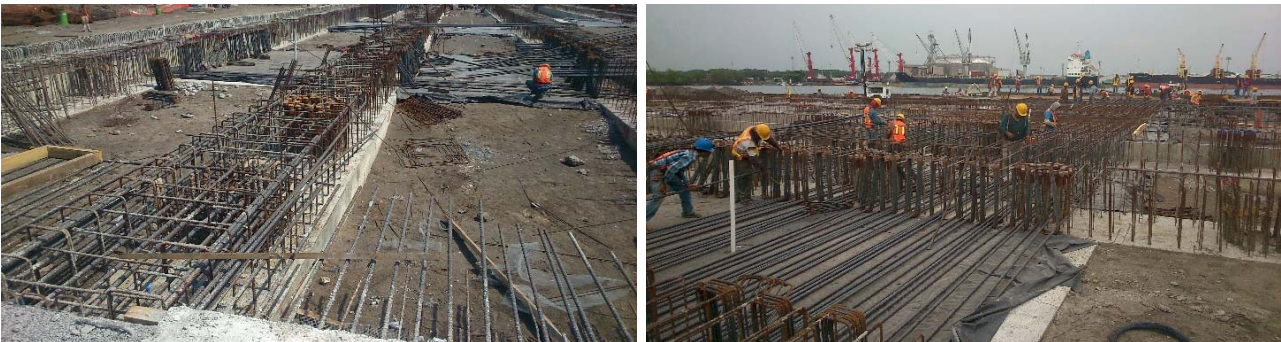
Figura 12a, 12b. Vista del armado de vigas longitudinales. Vista del armado de cara inferior de la losa en zona de fingers.
