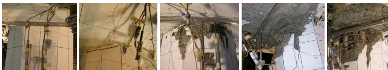
Figura 5a, 5b, 5c, 5d, 5e Vistas de ensayos con estados de daño progresivos en la rótula plástica en el encuentro de pilote con losa. DS1: Fisuración en el pilote, DS2: fisuración en la losa, DS3: spalling moderado en el pilote, DS4: spalling severo en el pilote y spalling en la losa, DS5: Pandeo de barras longitudinales comprimidas y rotura de cercos [5].
