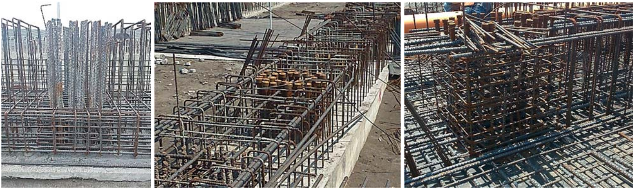
Figura 8a, 8b, 8c. Armado vertical del pilote y de fase 1 de viga longitudinal. Armado de fase 2 de viga longitudinal y terminales de anclaje de armadura vertical del pilote. Armado de fase 2 de viga longitudinal, armado de cara inferior de losa, confinamiento del nudo.
