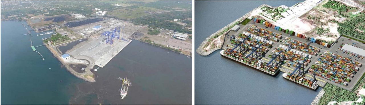
Figura 1a, 1b. Vistas Generales de la nueva terminal de contenedores de Puerto Quetzal.
