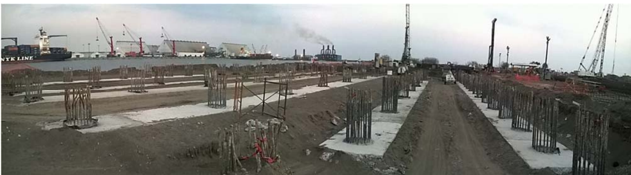
Figura 10. Vista de las alineaciones de vigas longitudinales y pilotes.
