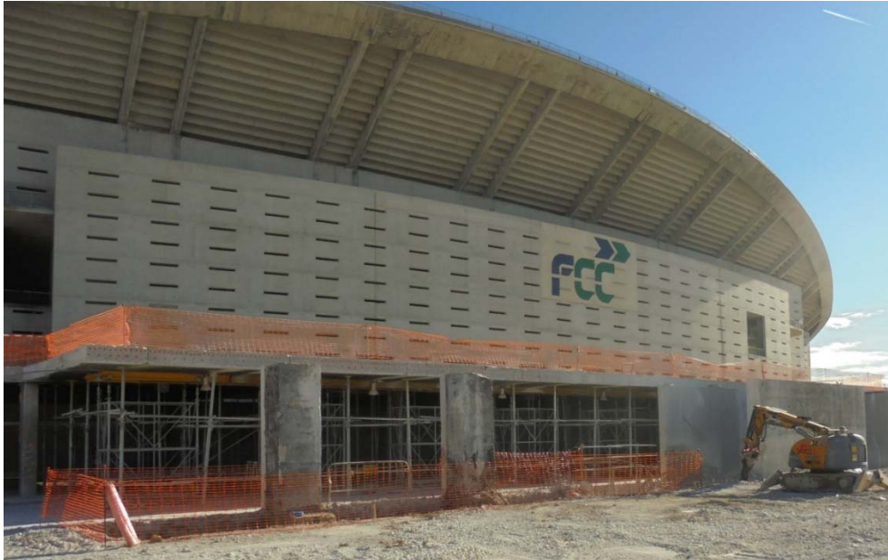
Figura 6. Demoliciones del muro dorsal y la losa de la cota 0.00
