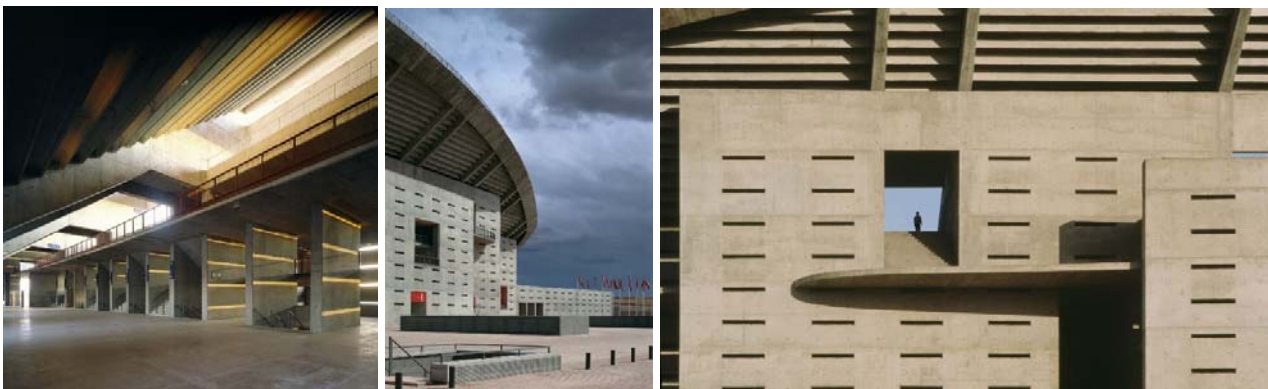
Figura 2. Imagen de los pórticos interiores y detalles de los muros exteriores del Estadio de Madrid
