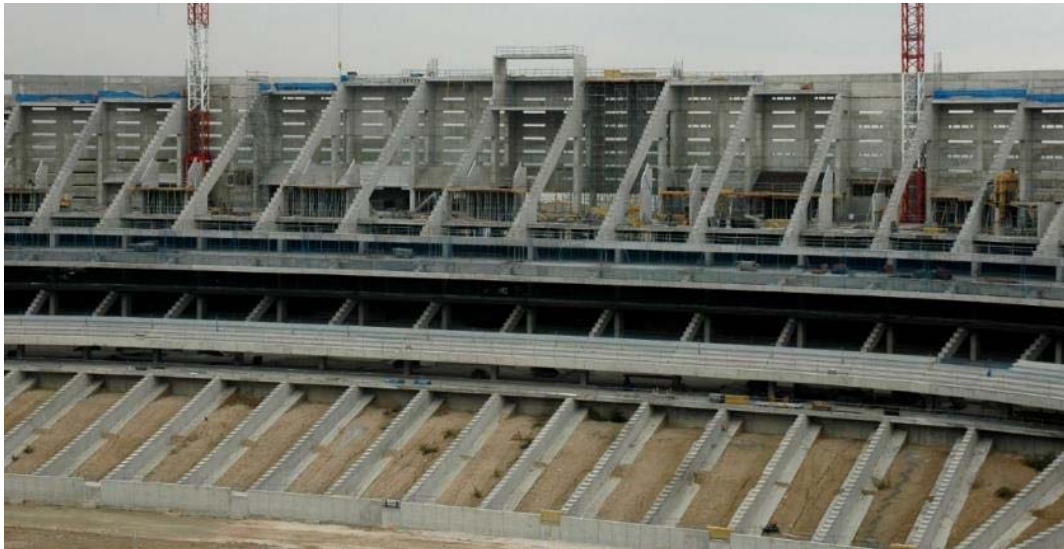
Figura 8. Pórticos de los tres graderíos en zona Este
