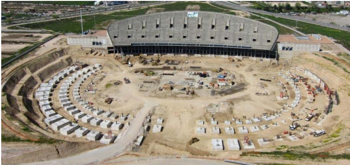
Figura 4. Vista general de las cimentaciones de la ampliación
