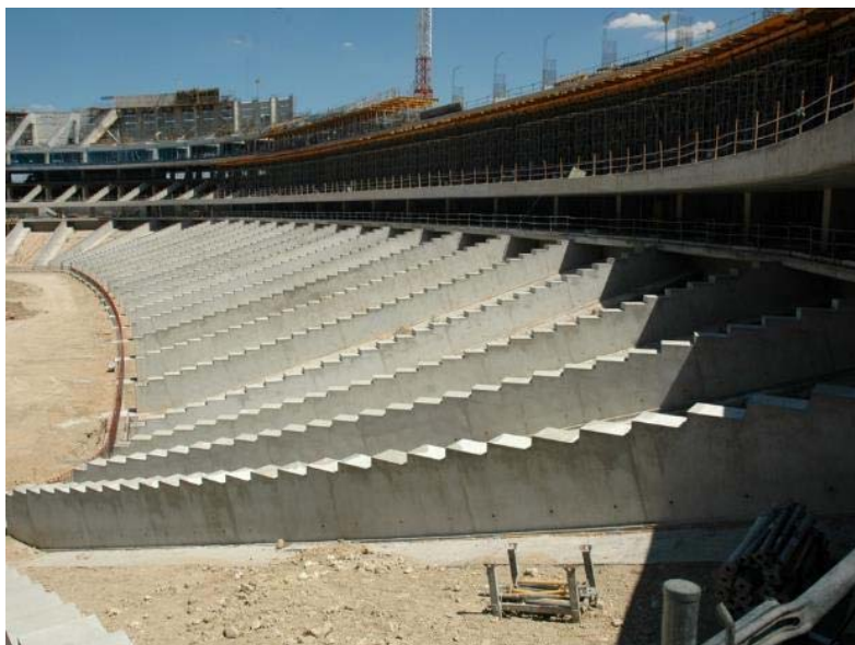
Figura 9. Pórticos del graderío bajo
