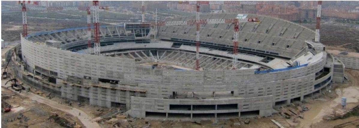
Figura 10. Muros perimetrales de la ampliación
