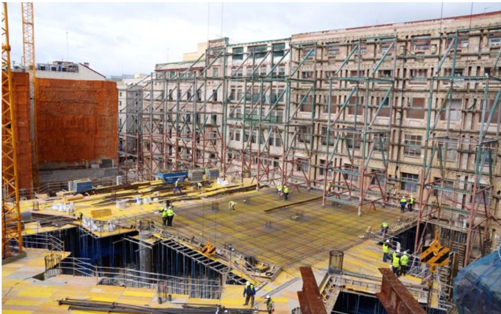
Figura 6. Vista del forjado de Planta 1 durante las labores de ferrallado.
