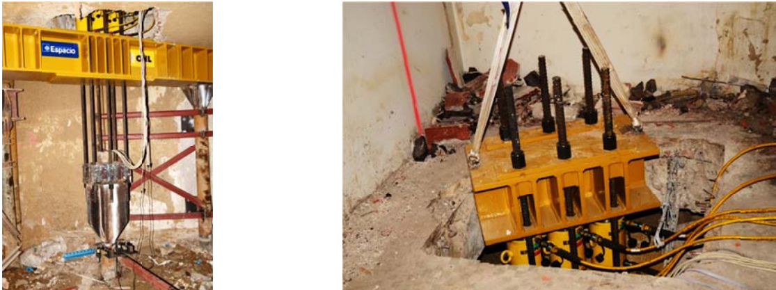
Figura 2. Ensayo de tracción de micropilotes.
