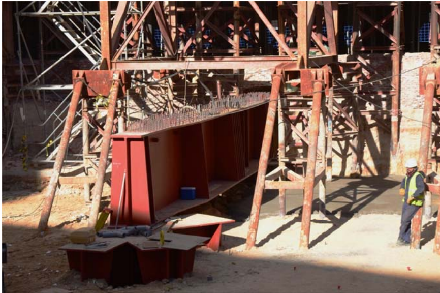
Figura 7. Imagen de una de las grandes vigas cargadero del Sótano 1 tras ser ubicada en su posición, al interior de un estabilizador
