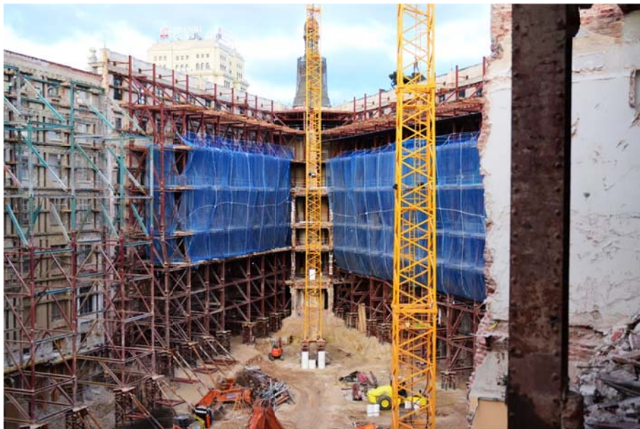
Figura 1. Vista general de los estabilizadores durante el proceso de demolición
