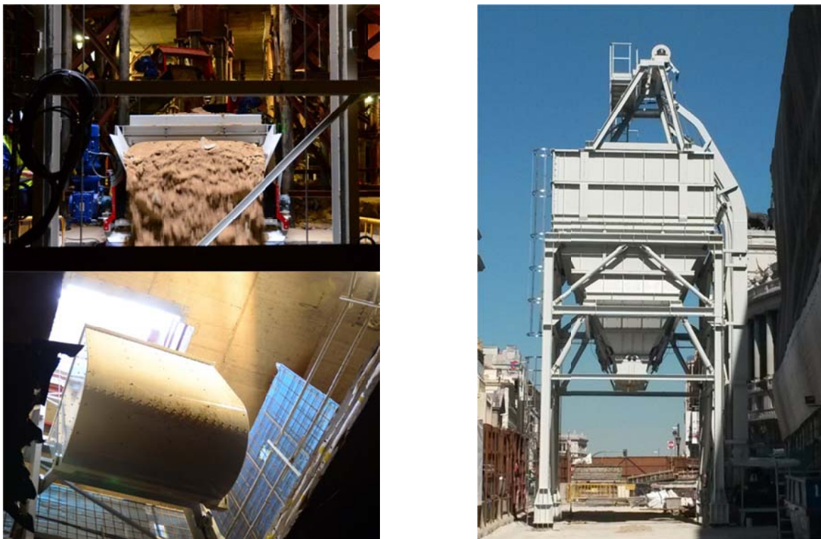
Figura 9. Sistema de extracción de tierras. En sentido antihorario: cinta de alimentación, ascenso del cangilón y tolva de almacenamiento
