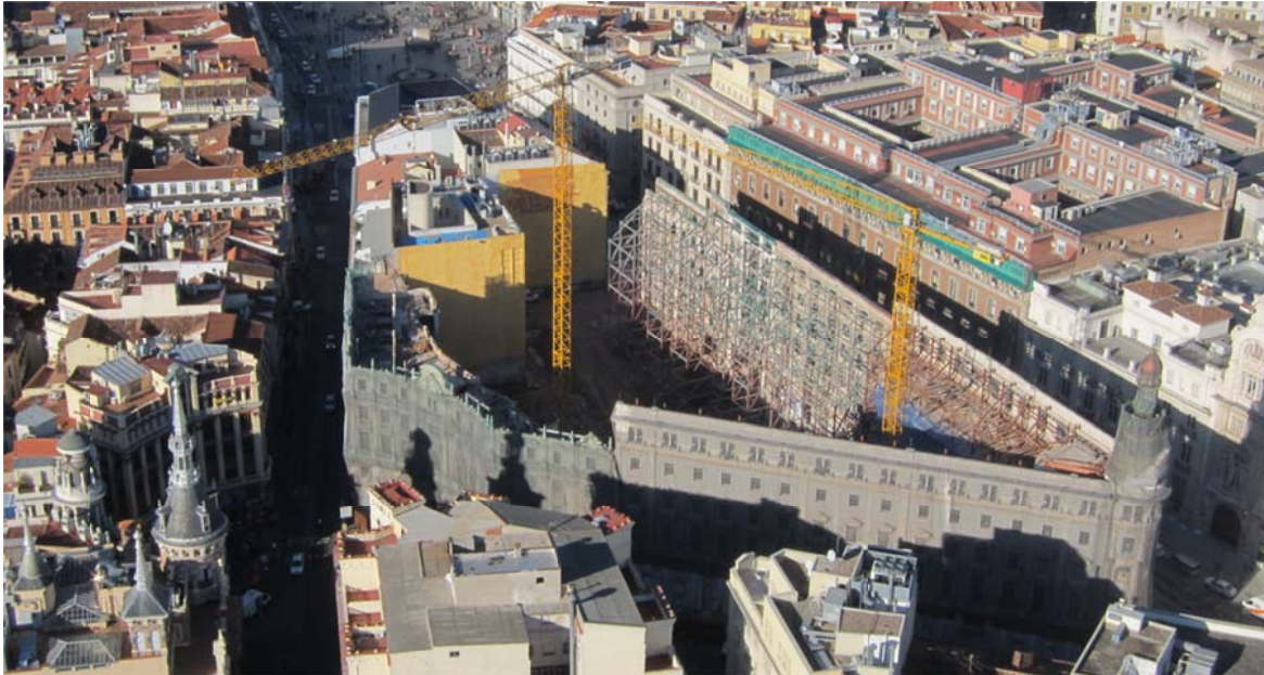
Figura 8. Vista área de la manzana tras la demolición interior de los edificios. Las fachadas se mantienen en su posición gracias a los sistemas de estabilización y apeo.
