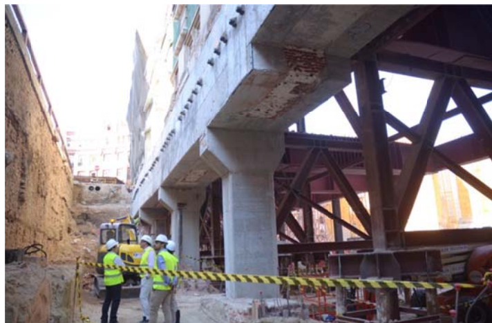
Figura 10. Vista de los soportes y de la viga de apeo de fachada en la alineación de Sevilla.
