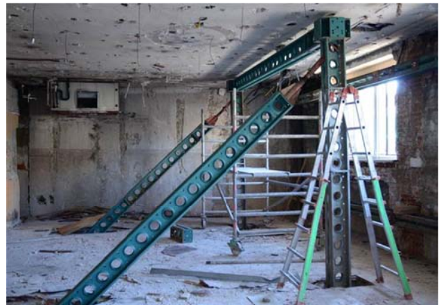
Figura 7. Montaje de la parte superior del estabilizador
