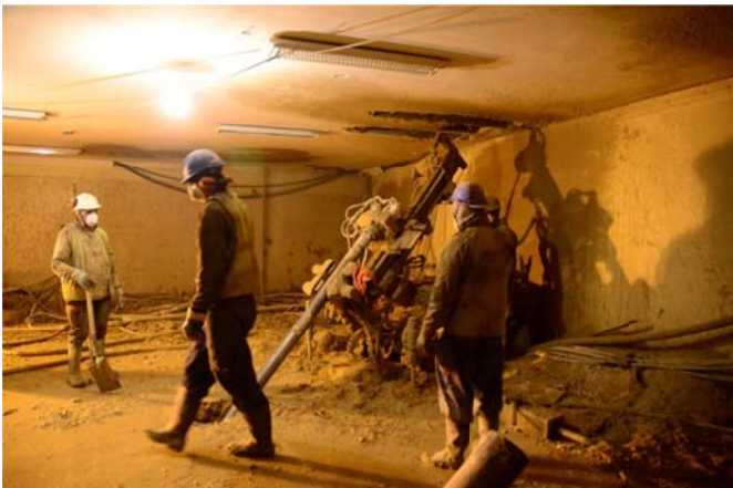
Figura 6. Ejecución de micropilotes con gálbo reducido
