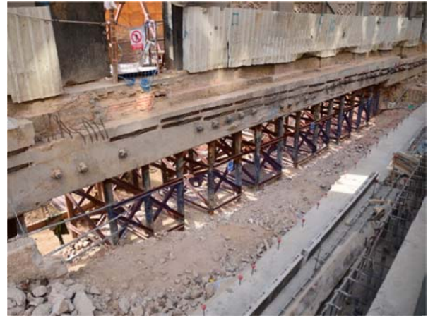
Figura 4. Vista en perspectiva de la fachada de Alcalá 8 tras la demolición del muro de sótano. La fachada apoya sobre el sistema de apeo.
