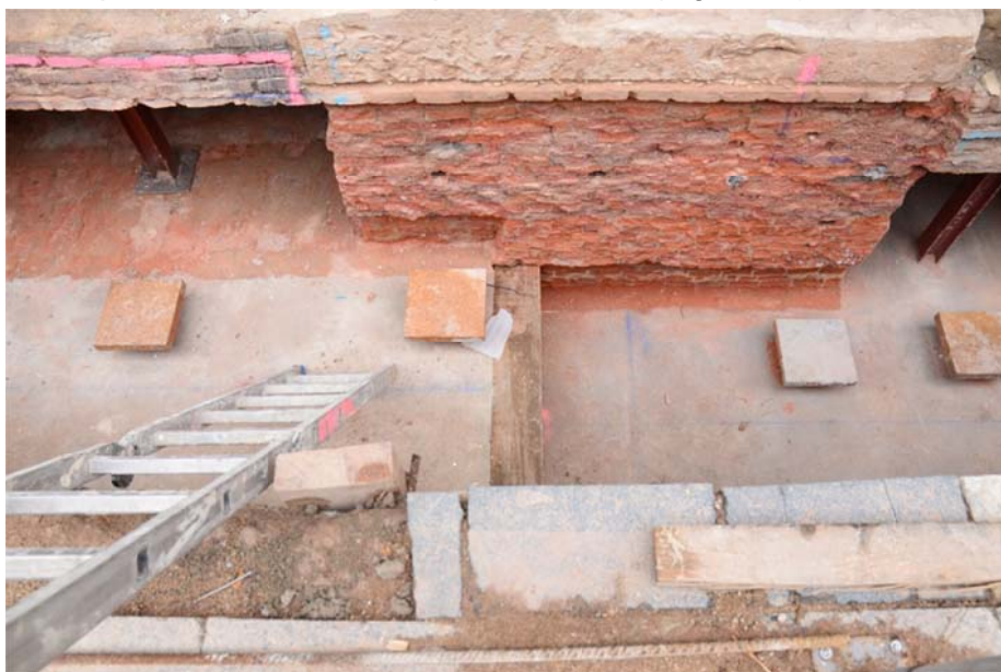
Figura 13. Vista del tramo de muro de sótano bajo machón de fachada durante la ejecución de las vigas gemelas
