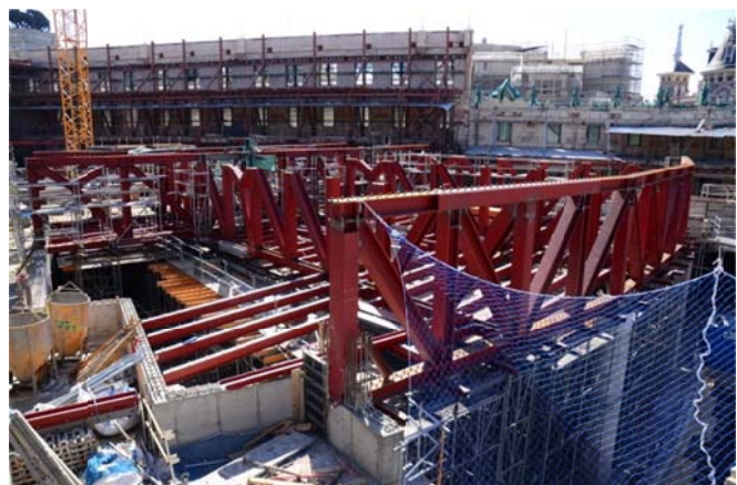
Figura 10. Vista del montaje de las celosías
