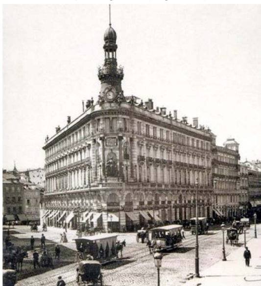
Figura 2. Vista del edificio de la Equitativa a principios del s. XX
