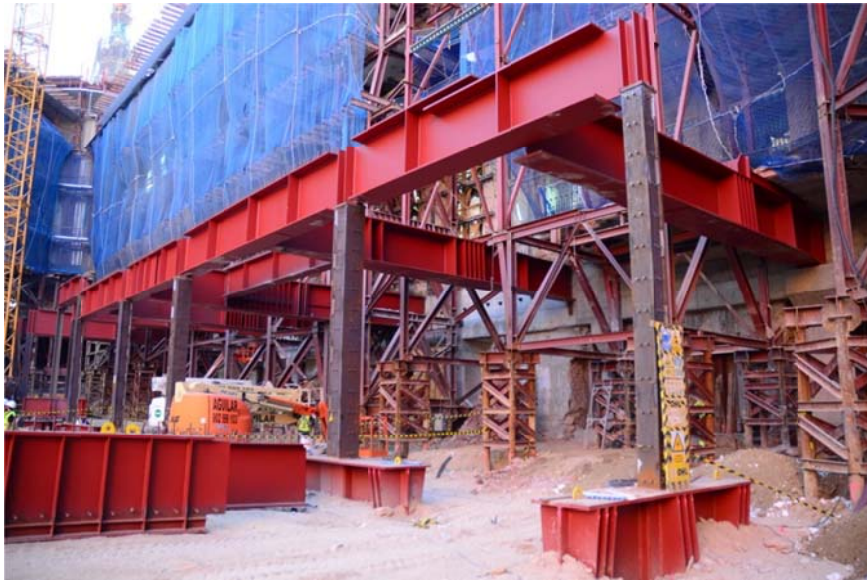
Figura 8. Vigas de apeo de soportes asociadas al nivel de Planta Baja
