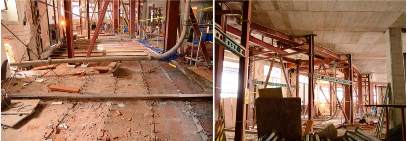
Figura 6. Vista de las actuaciones en la primera cruzía. A la izquierda, viguetas originales a las que se le han soldado los pernos conectadores, previamente al ferrallado y hormigonado de la nueva capa de compresión. A la derecha, viga de transición entre primera cruzía y estructura interior discurriendo entre los estabilizadores provisionales de fachada.
