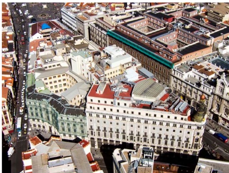
Figura 1. Vista general de la manzana de Canalejas en la situación previa a la intervención. En primer plano, los dos edificios emblemáticos del conjunto: La Equitativa (a la derecha, con torreón) y el Banco Hispano-Americano (izquierda, cubierto por una malla)
