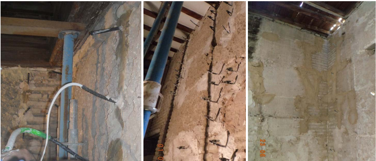
Figura 4. Inyección de fisuras en muros y conexión/cosido de esquinas
