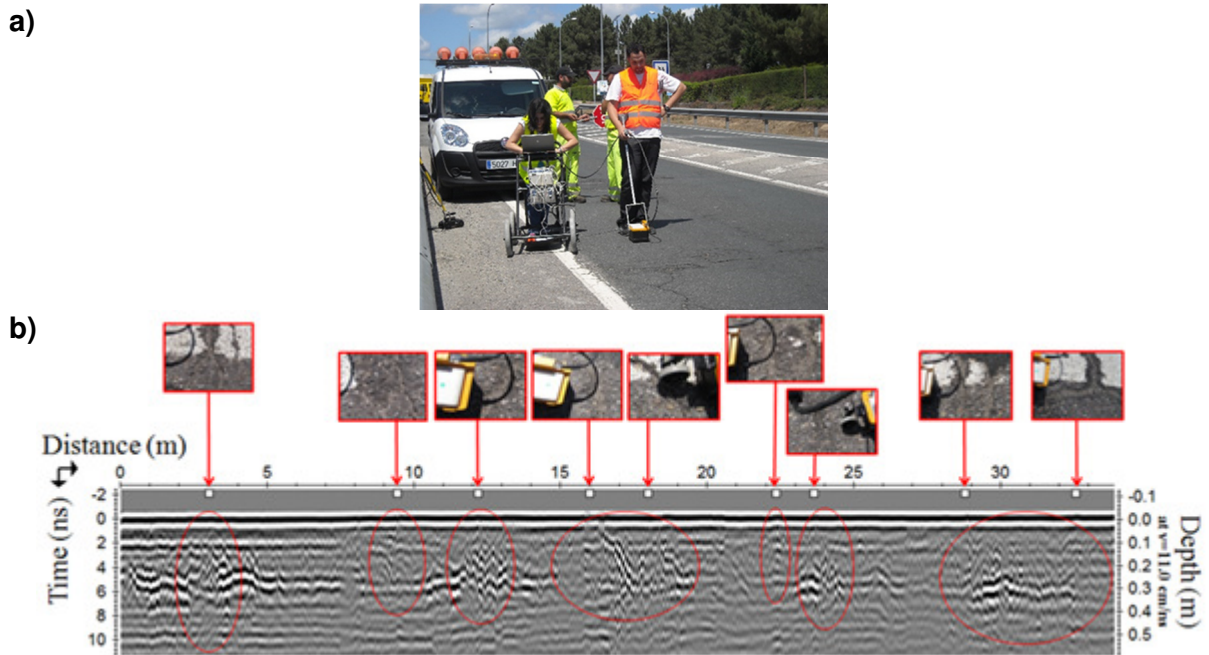
Figura 7. Análisis de rodadura con GPR sobre carro adaptado (a) en la carretera OU-537 (Ourense) y radargrama (b) con las principales patologías detectadas. Antena de 2,3 GHz [12].
