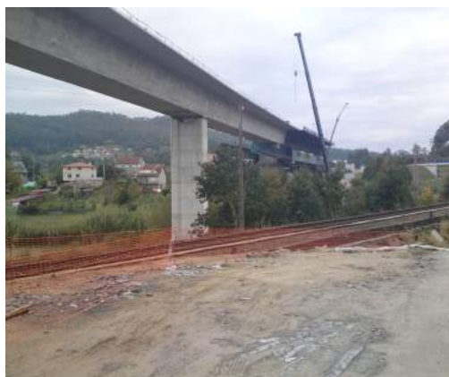
Figura 1. Alzado del viaducto de O Marco
