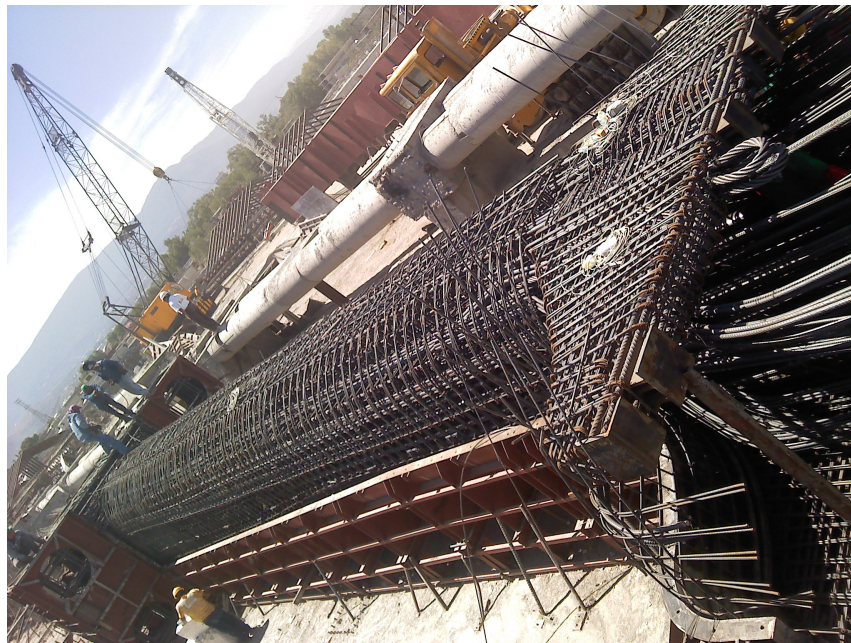
Figura 2. Instrumentación de la zapata-columna ZC049
