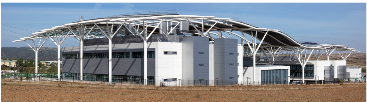
Figura 9 Marquesina de fase 1 construida
