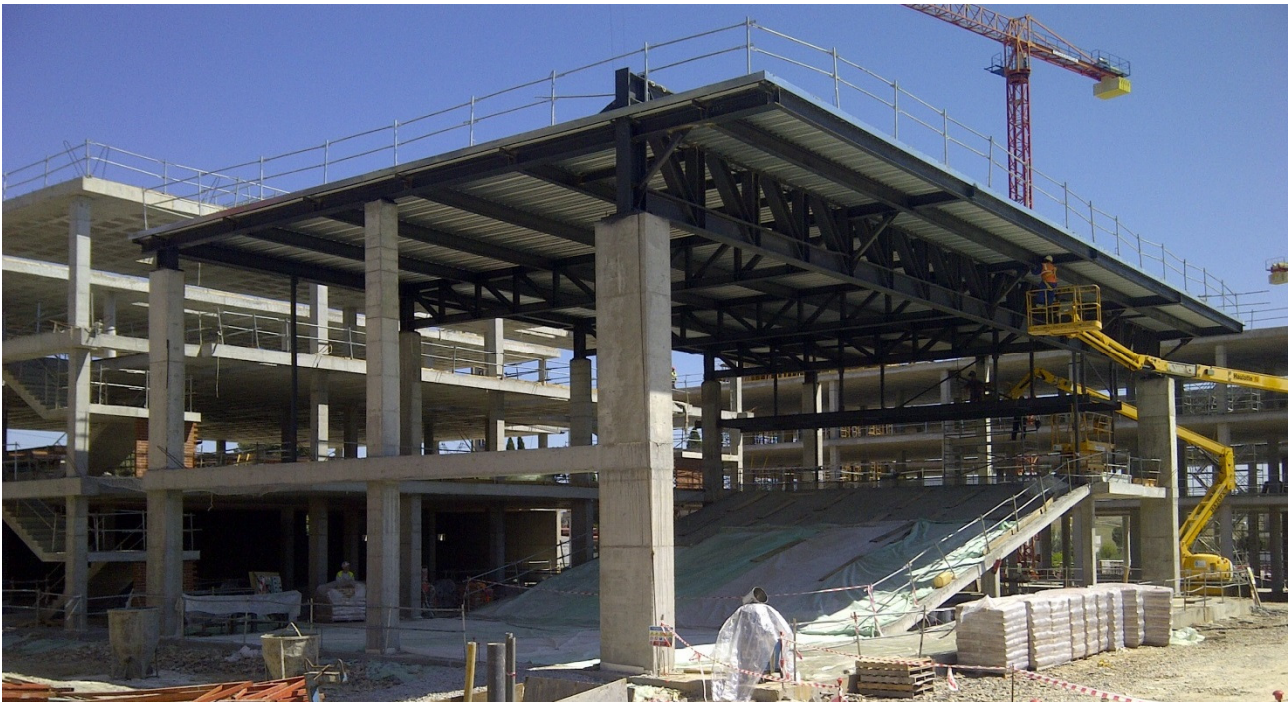
Figura 6 Vista del auditorio del Edificio 6 mostrando las cerchas ejecutadas
