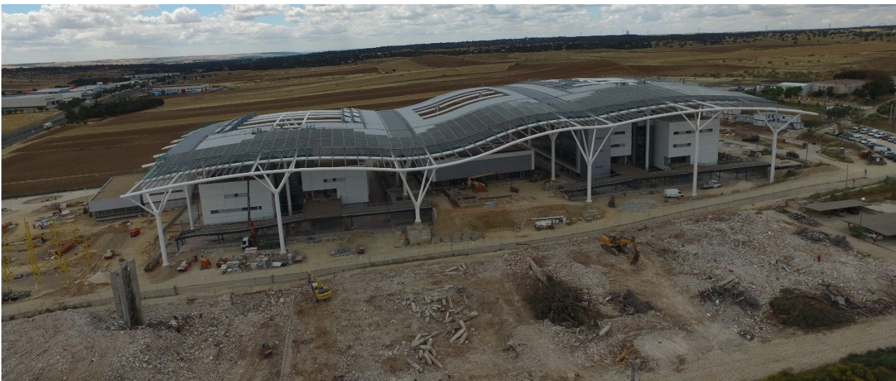
Figura 3 Vista general de la obra a mediados del 2016 mostrando la construcción de fase 1 ya muy avanzada y la demolición de fase 2 prácticamente concluida
