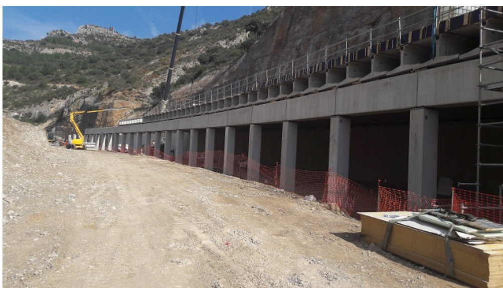
Figura 9. Vista de las vigas en T invertida
