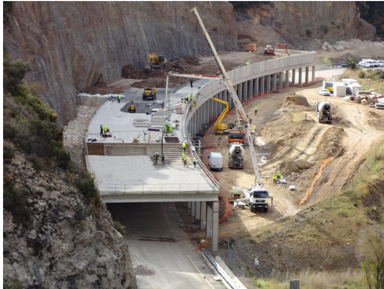
Figura 10. Vista de galería en fase de colocación de impostas
