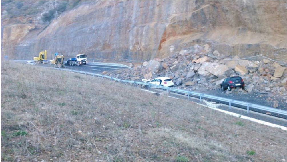
Figura 1. Panorámica del desprendimiento.
