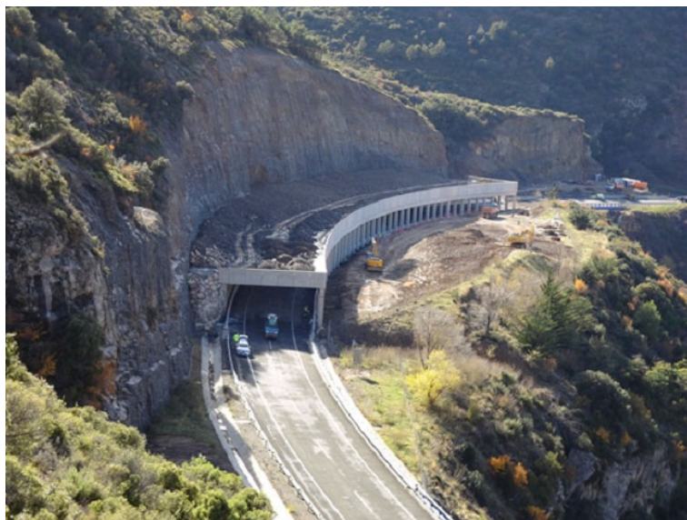
Figura 11. Vista de galería terminada, en fase de relleno de tierras
