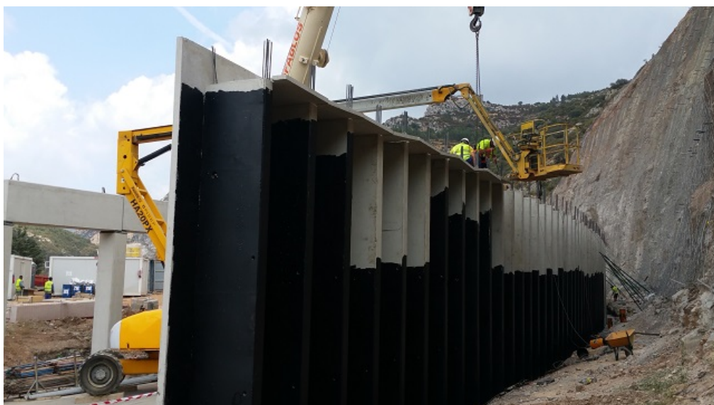
Figura 7. Colocación de prelasas para encofrado de cargaderos.
