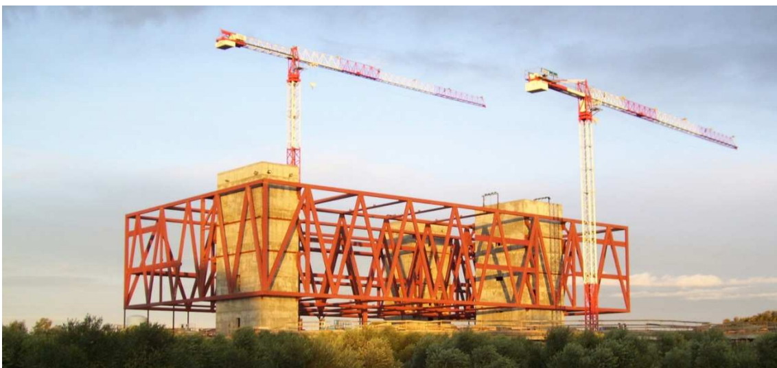
Figura 7. Vista general de la estructura metálica en la fase final de su ejecución. (Imagen propia)
