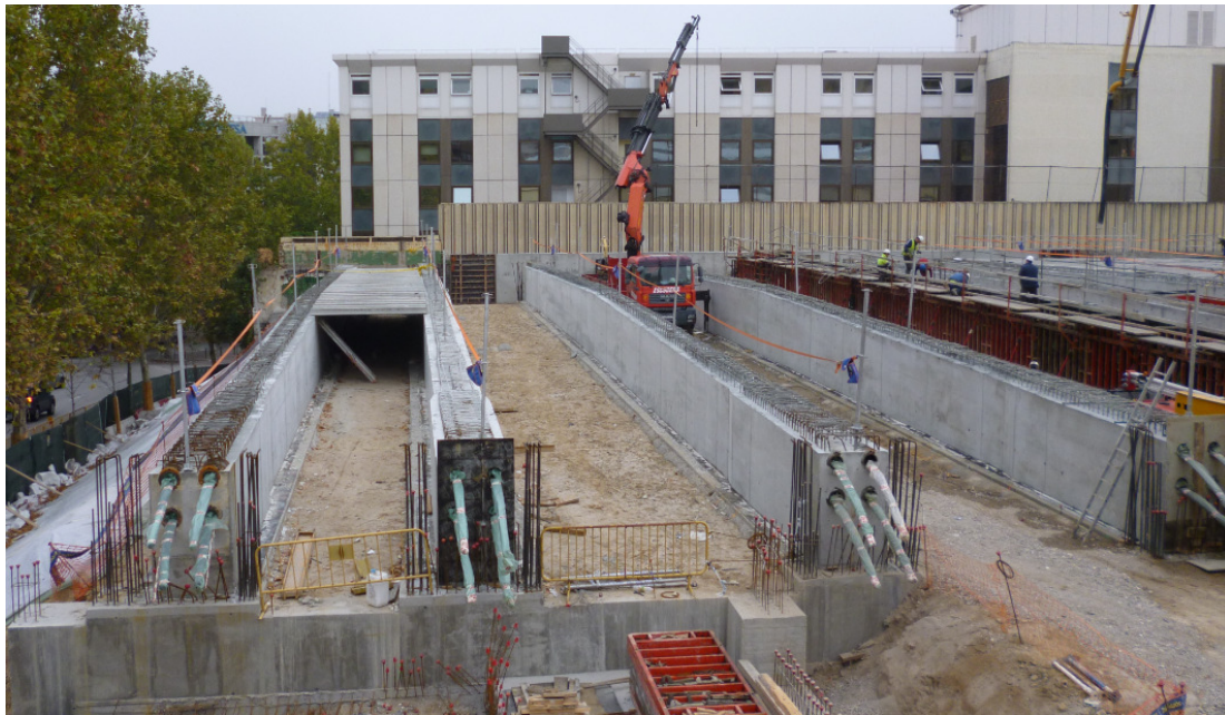
Figura 6. Hormigonado de vigas contra el terreno
