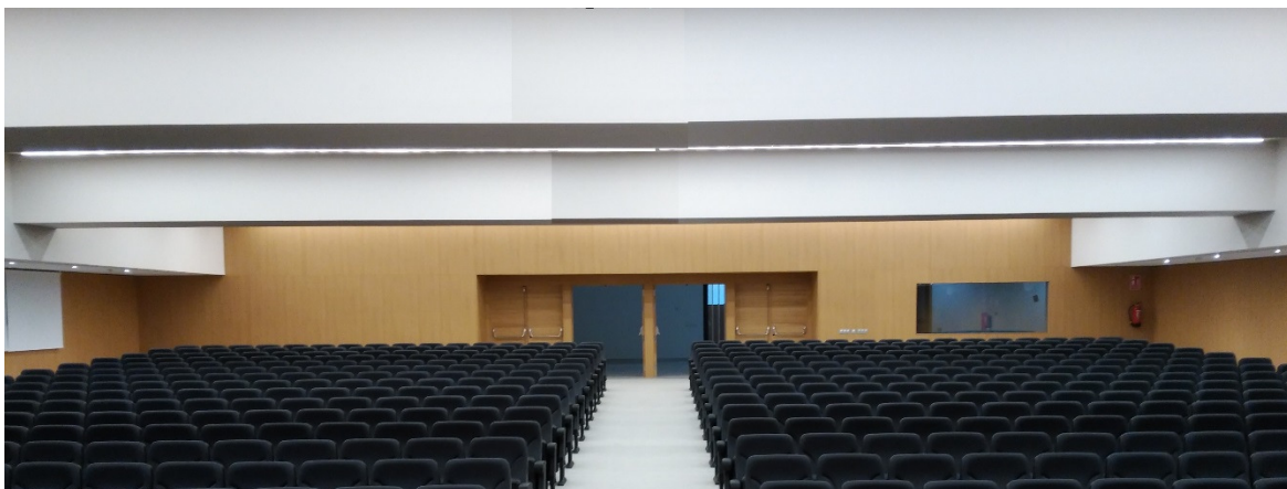
Figura 10. Viga postesada auditorio.
